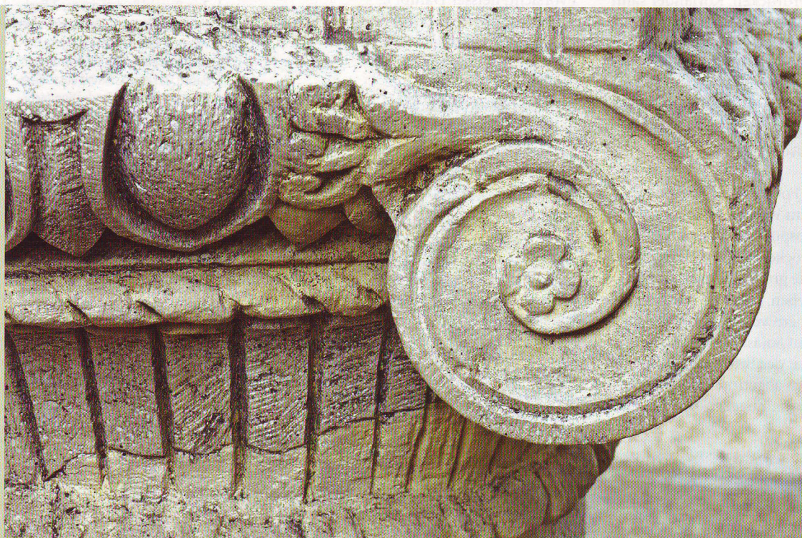
Ionisches Kapitell, der obere Abschluss einer Säule. *Augusta Raurica
